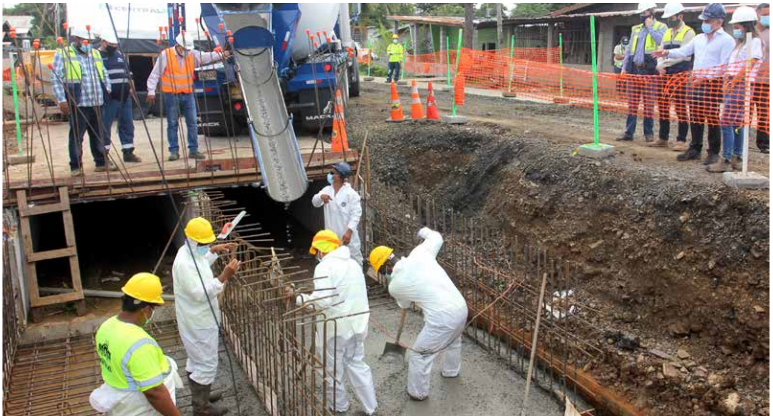
Formaleta para cajón pluvial en la calle Aristides Arjona, en Concepción La Vieja.
