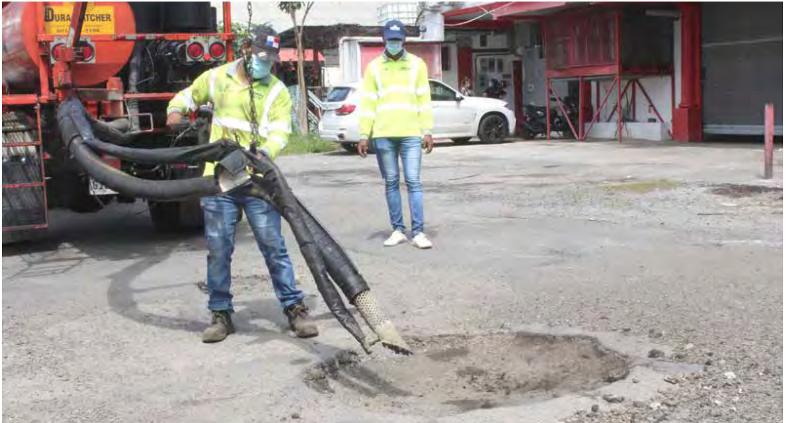
Jornada de capacitación práctica en donde se realizaron los trabajos de pruebas con el camión "tapahuecos".
