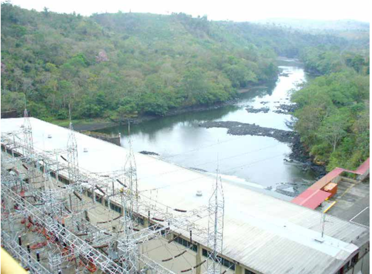
Central Hidroeléctrica Bayano
