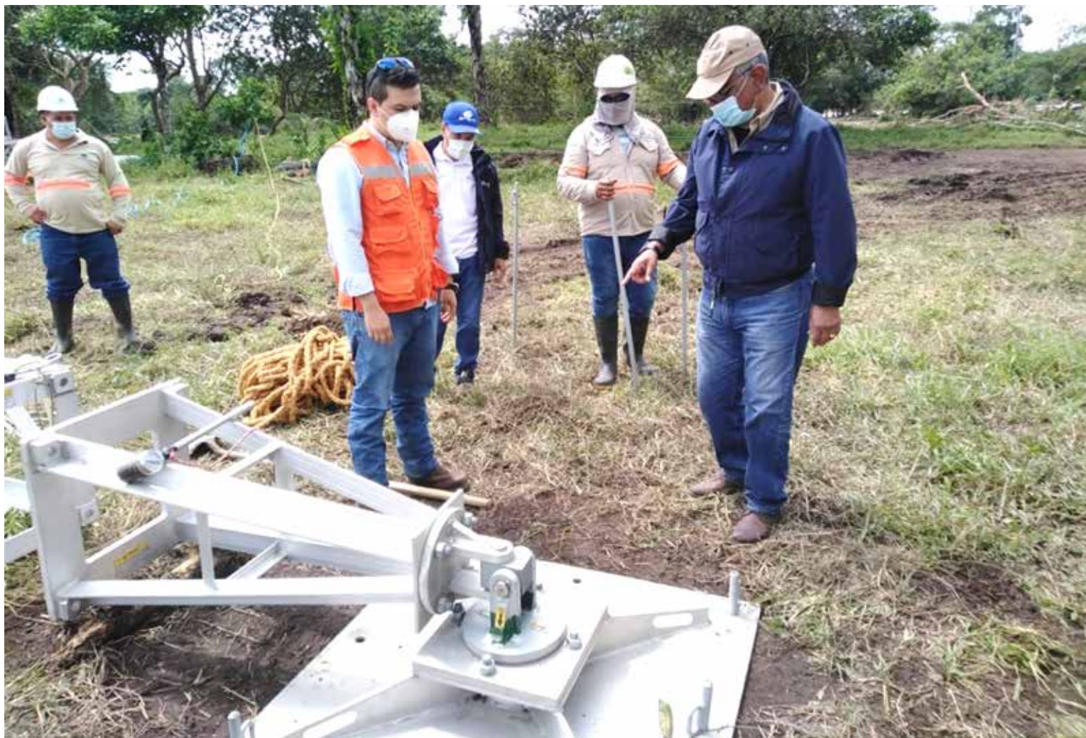
Carlos Mosquera, gerente de ETESA, realiza una inspección de daños ocasionados en el sistema de transmisión.
