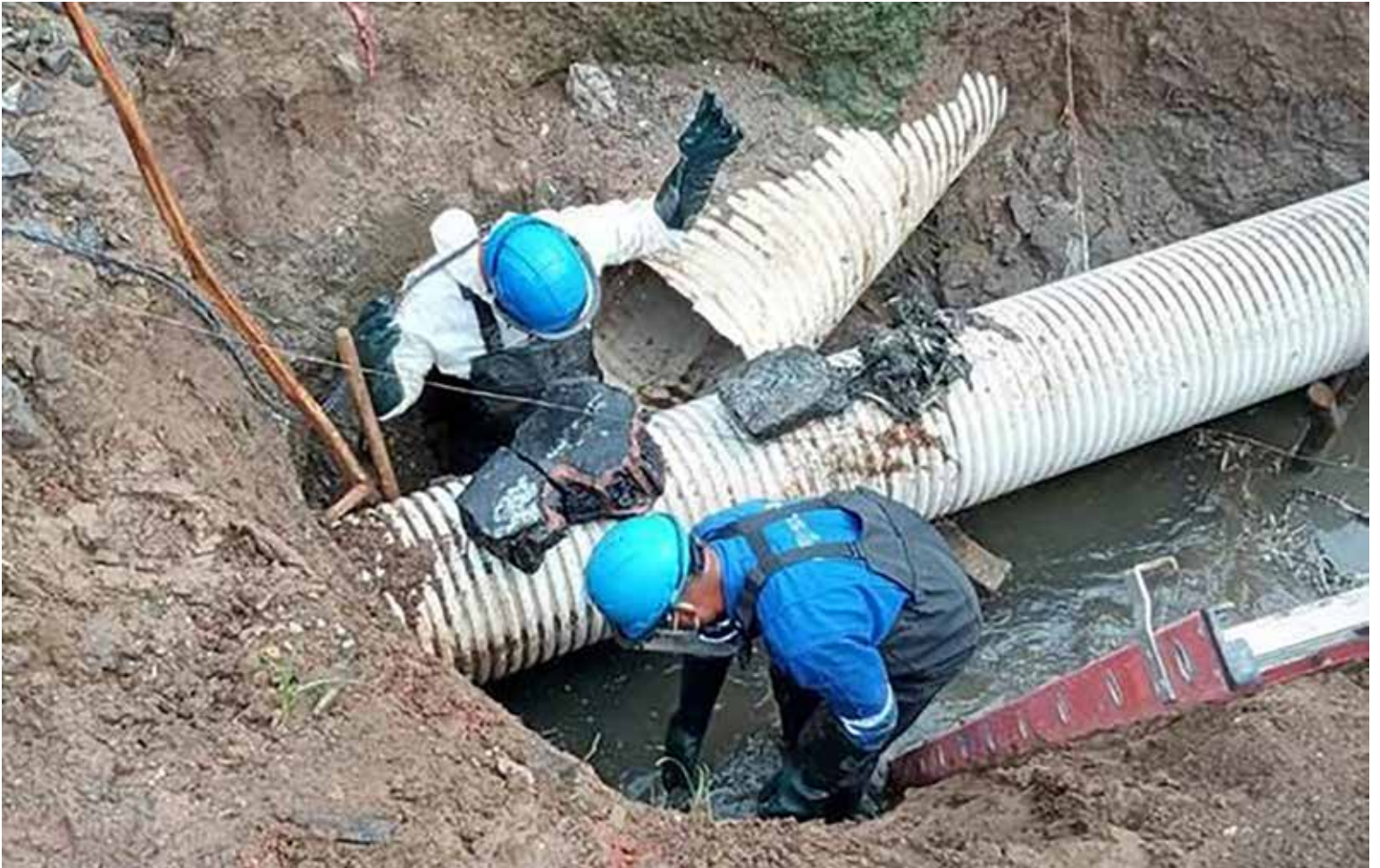
El equipo técnico del Programa Saneamiento de Panamá, en conjunto con la empresa contratista.
