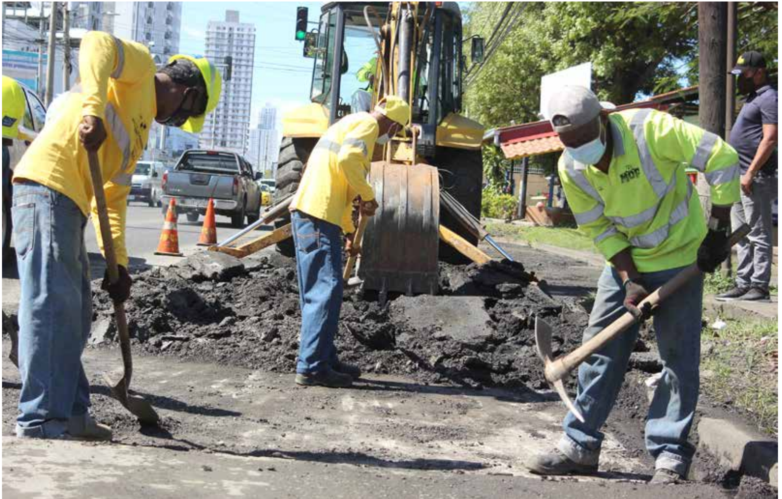
Cuadrillas del MOP realizan trabajos de bacheo profundo en Río Abajo.
