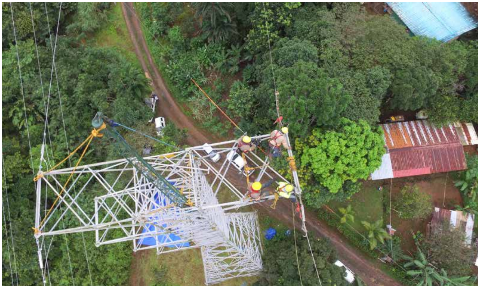
Equipo de ETESA durante las labores de desarmado de la torre en Colón.
