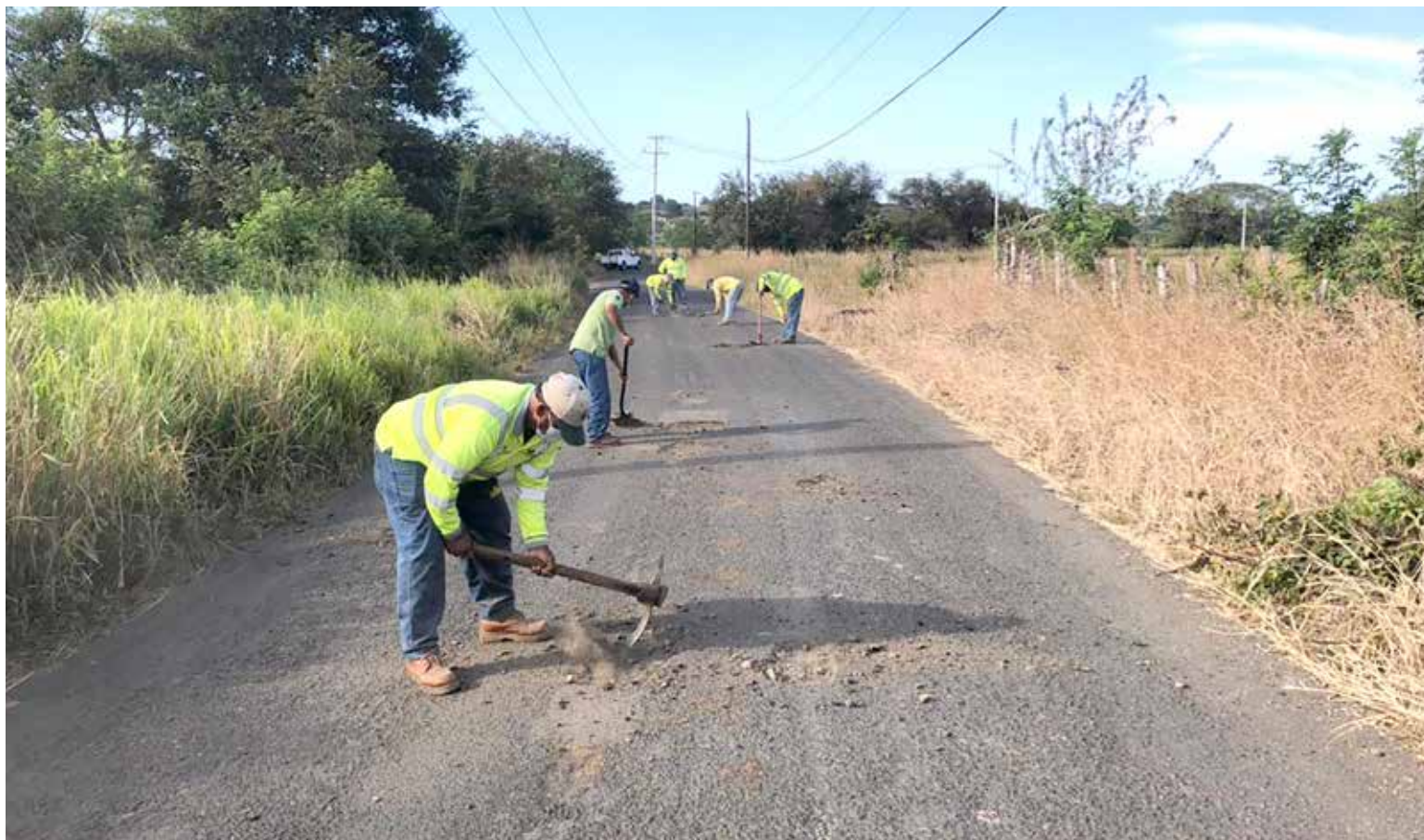
Trabajadores del MOP reparan calles.
