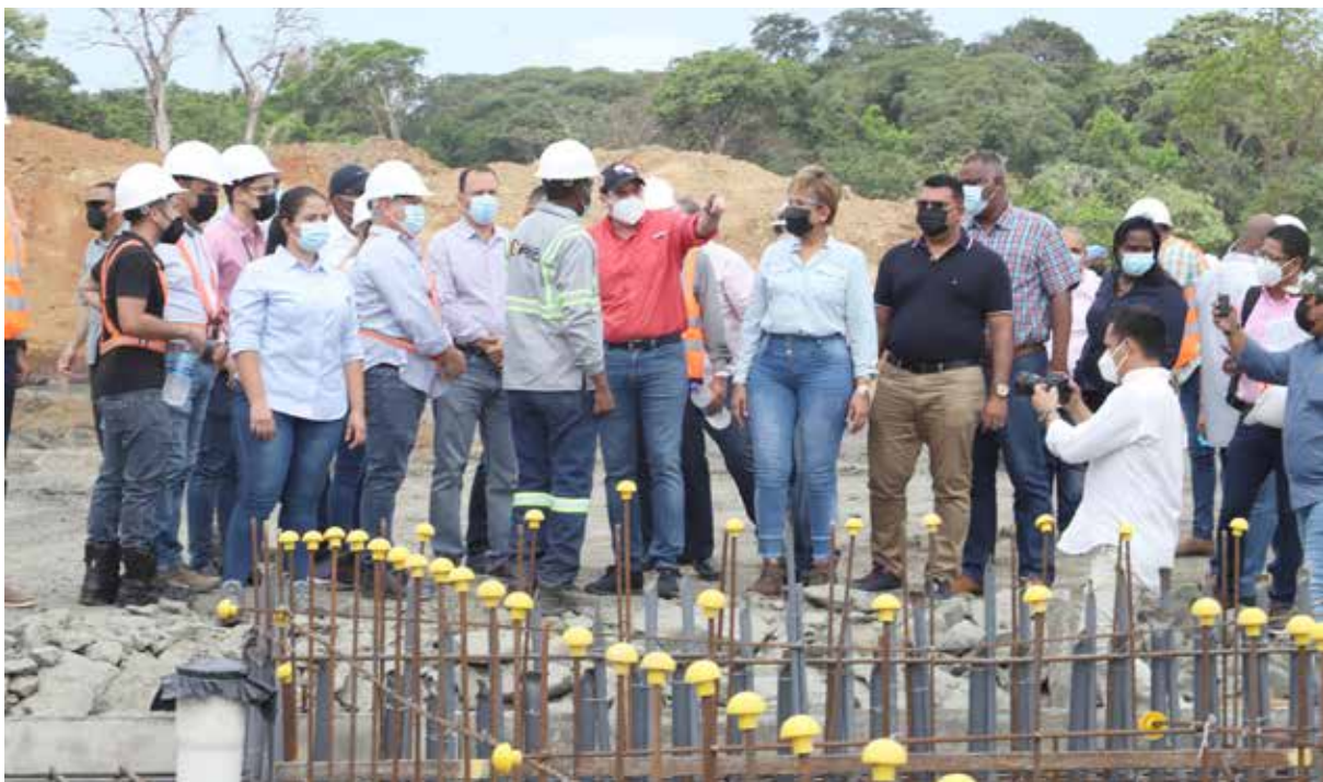
La construcción de la segunda etapa de Altos de Los Lagos, fue visitada por el vicepresidente de la República, José Gabriel Carrizo Jaén, donde 1,620 familias, que viven en albergues o en asentamientos informales, se mudarán a este proyecto que cuenta con áreas deportivas.
