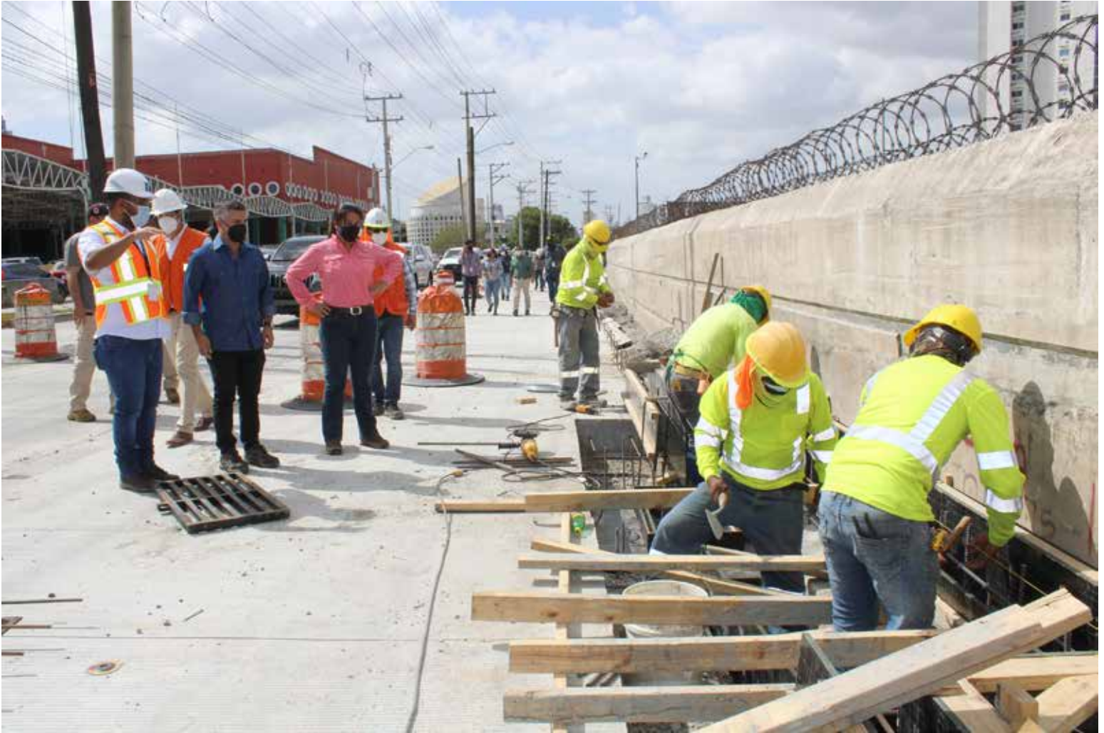
Gilberto Marengo, director de Proyectos Especiales del MOP, explica al ministro Rafael Sabonge y a la viceministra Librada De Frías, los avances del proyecto de la vía Transísmica a la altura de plaza Ágora.
