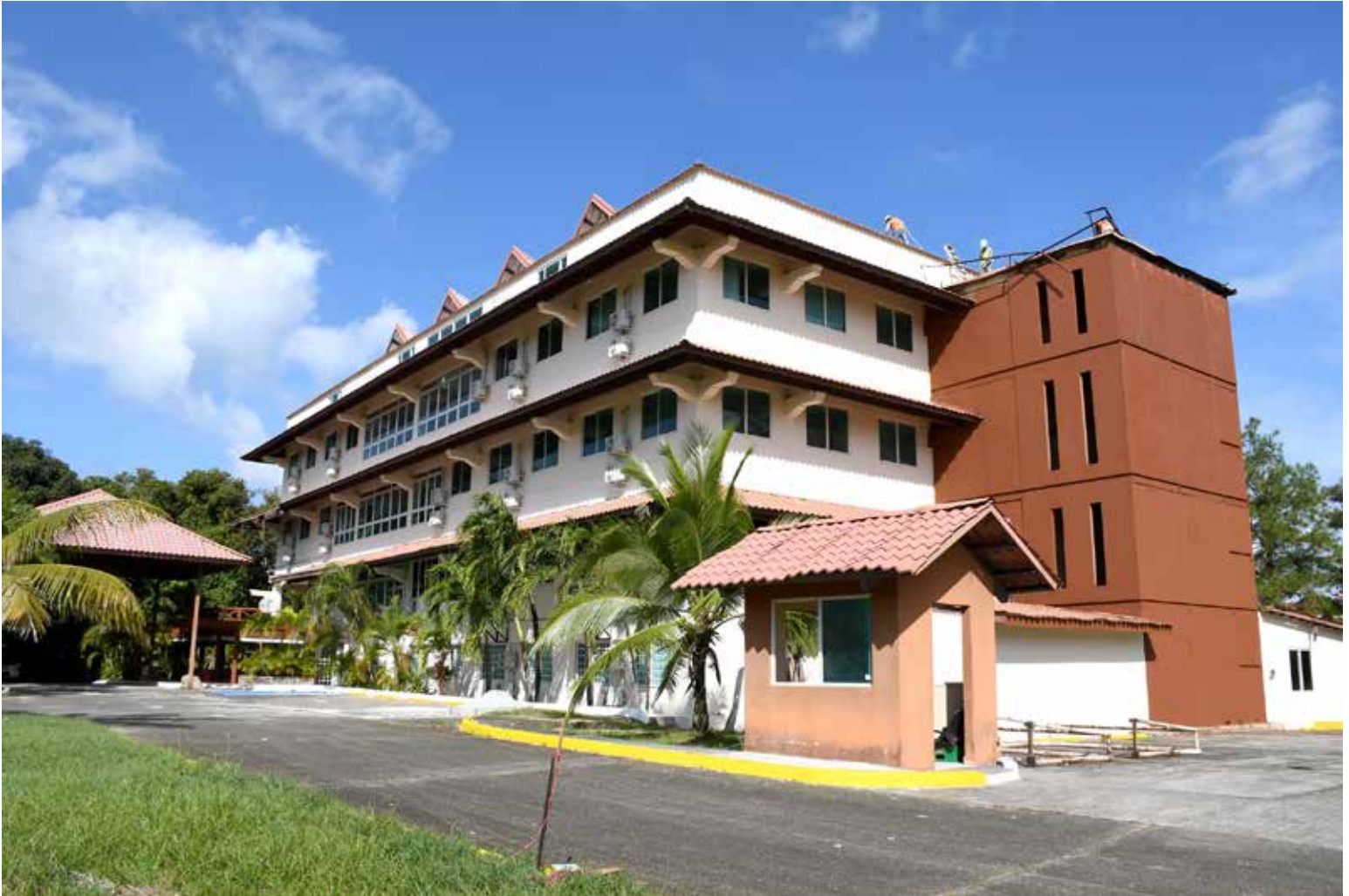
Fachada de las instalaciones rehabilitadas del hotel hospital de Colón, que consta de 90 habitaciones.
