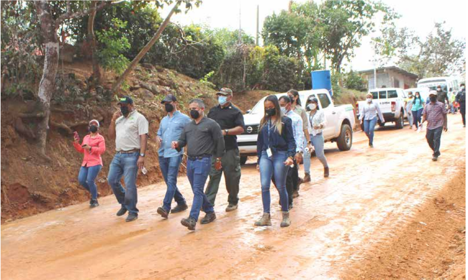
El ministro de Obras Públicas, Rafael Sabonge, inspecciona trabajos en la vía Altos de Pedregal - Santa Cruz.
