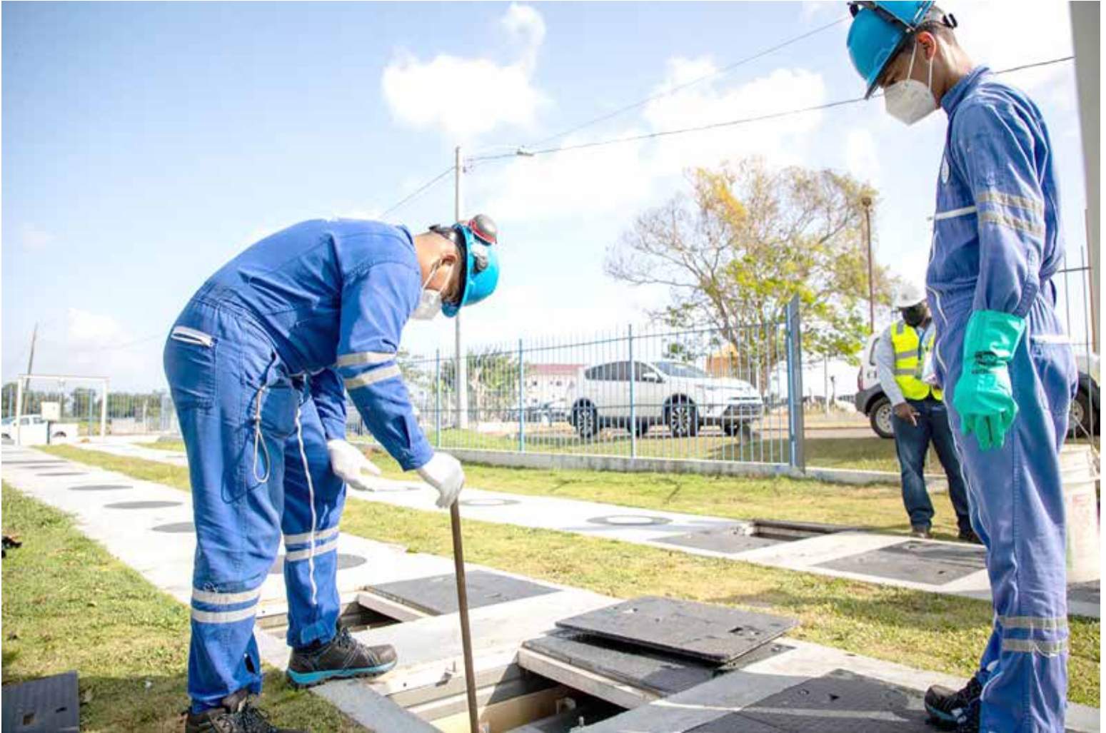
Personal del Programa Saneamiento de Panamá realiza trabajos de operación y mantenimiento a la Planta de Tratamiento del Hospital Nicolás Solano, de La Chorrera.
