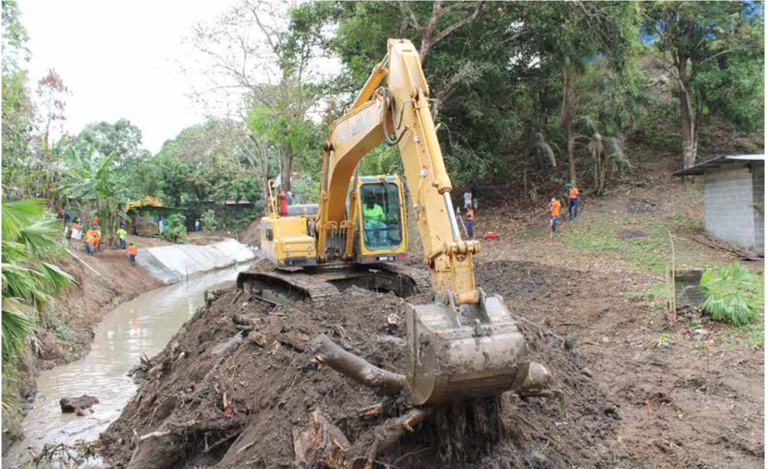
Trabajos de canalización de la quebrada Sonsonato, en Chivo-Chivo.
