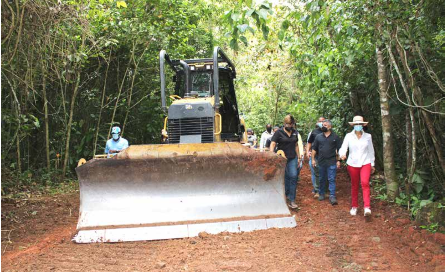
Labores de nivelación del terreno se realizan en el proyecto de rehabilitación de la vía que conduce hacia el Fuerte de San Lorenzo.
