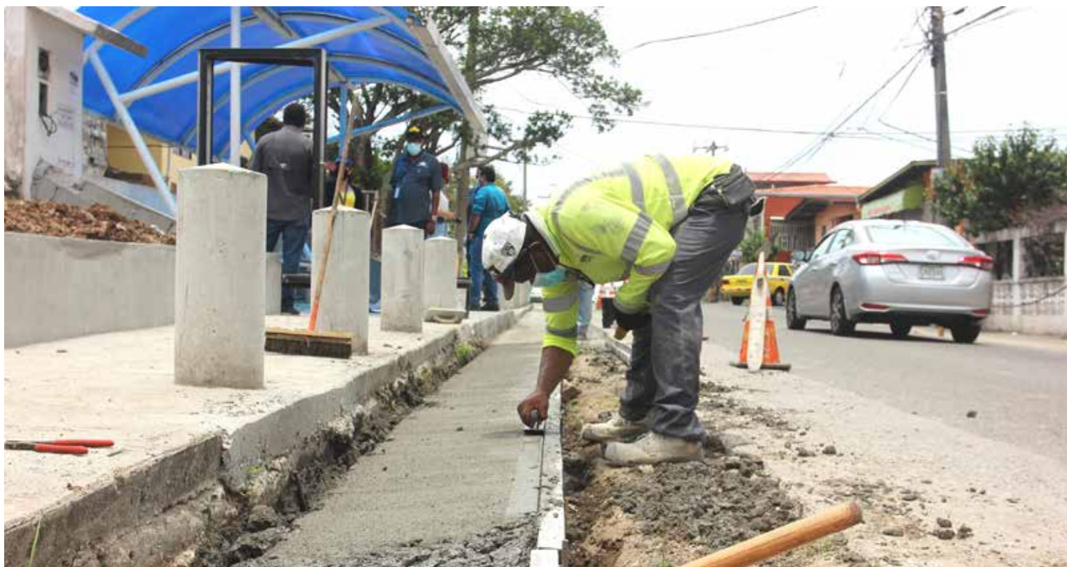
Mayor acceso y seguridad a residentes brinda la construcción de veredas en San Miguelito.
