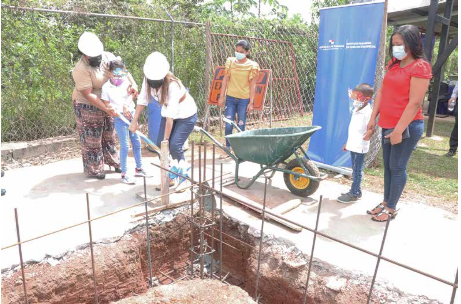
Autoridades, estudiantes y padres de familia, durante la colocación de la primera piedra de la construcción de dos talleres para carreras técnicas intermedias.
