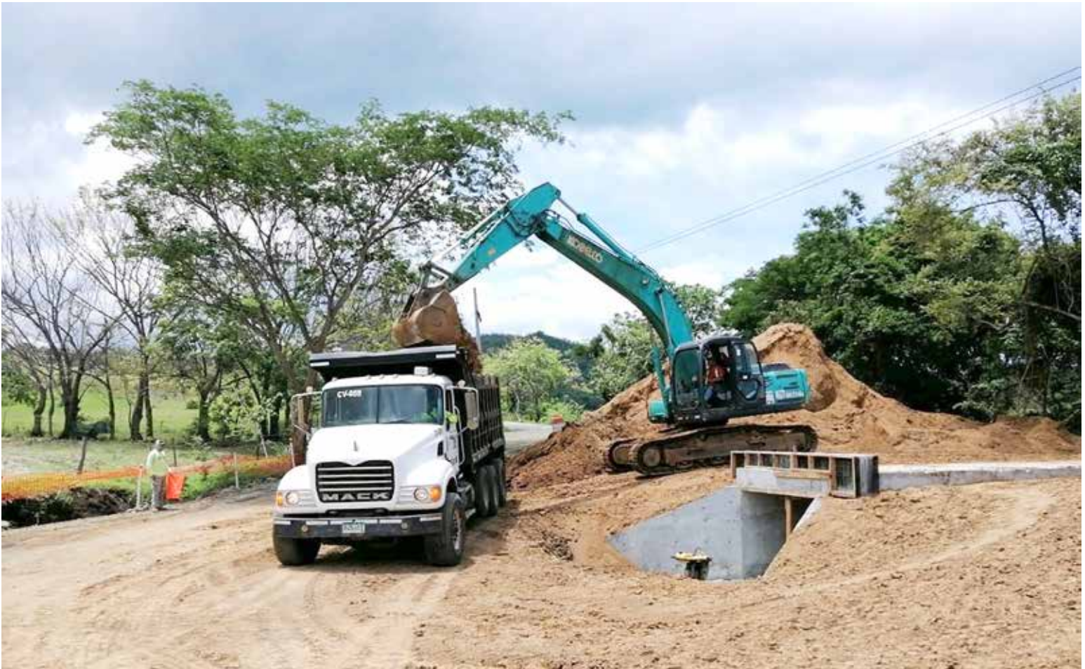
La rehabilitación de la vía Pedasí - Los Asientos - Cañas está casi lista.
