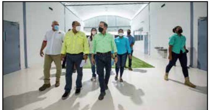
Se supervisó la construcción del CEBG Ernesto T. Lefevre, que tiene un avance de 99.42%.
