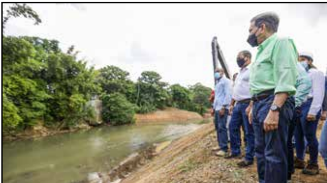
Inspección en el dragado del río Juan Díaz, cuya inversión asciende a B/.6,652,832.00.
