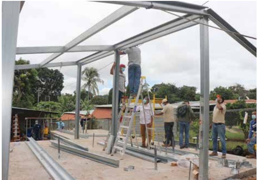
Cuadrillas del Miviot trabajan en la construcción de nuevas residencias.
