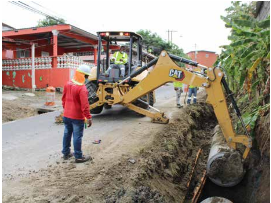
Personal del MOP coloca tubería de hormigón reforzado en la barriada 9 de Enero para el manejo de aguas en los sistemas pluviales.
