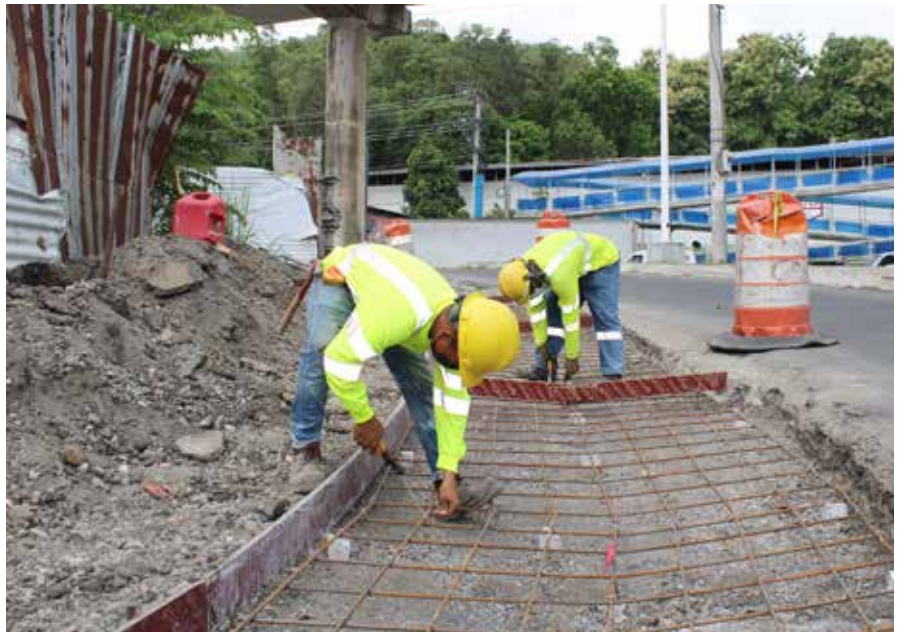
Construyen cunetas llaneras en la entrada de San Isidro.
