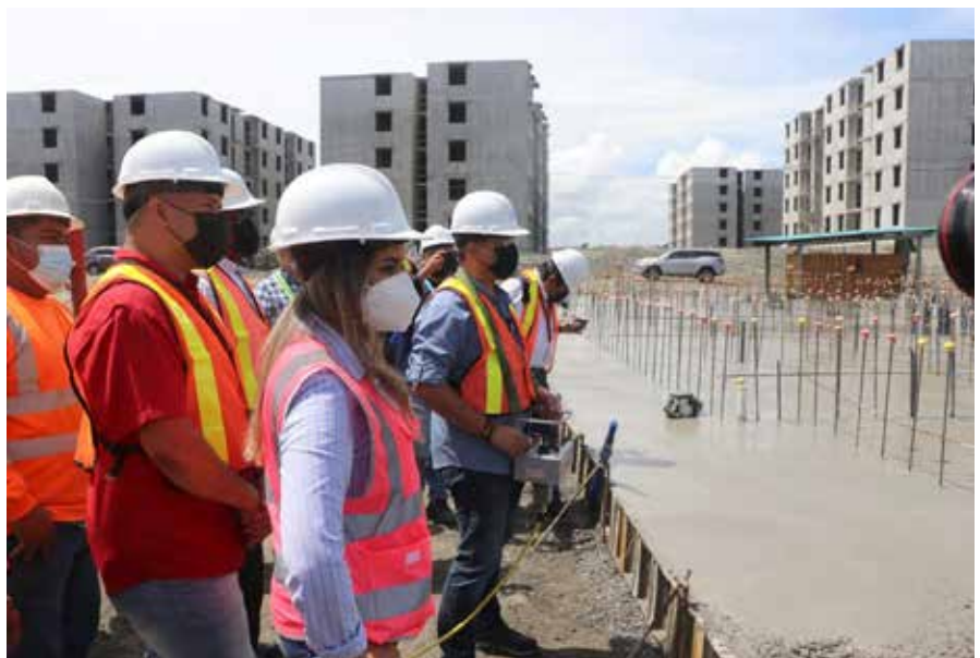
Durante el recorrido, el ministro Rogelio Paredes encabezó el acto simbólico de vaciado de 187 metros cúbicos de concreto en la fundación del edificio número 37.
