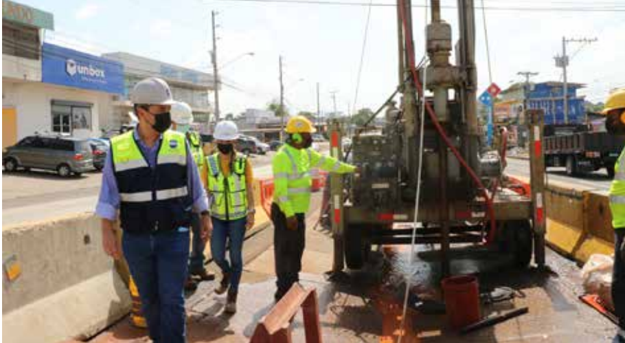
El director del Metro de Panamá, Héctor Ortega, en Vista Alegre, Arraiján, donde se realizan sondeos de suelo.
