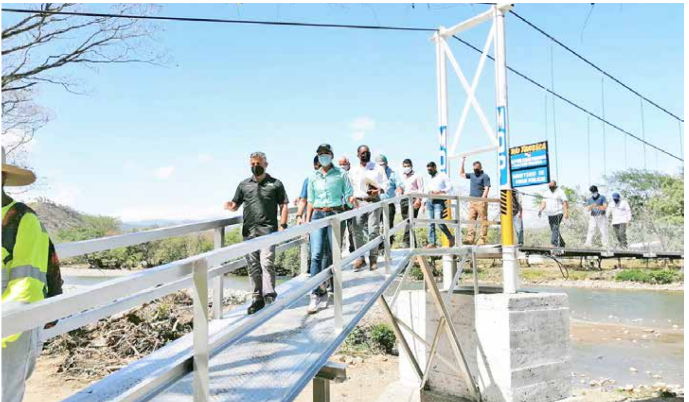
Una de las obras impactadas por los huracanes Eta e Iota en noviembre de 2020 fue el puente de zarzo de Paso Ganado.
