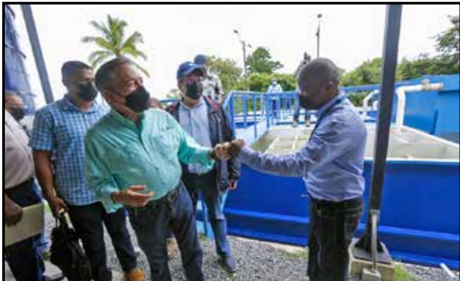
Se entregaron los trabajos de mejoras realizados a la Planta Potabilizadora de San Carlos, que beneficia a 11,600 usuarios y que alcanzó una inversión de B/.2,219,519.00.
