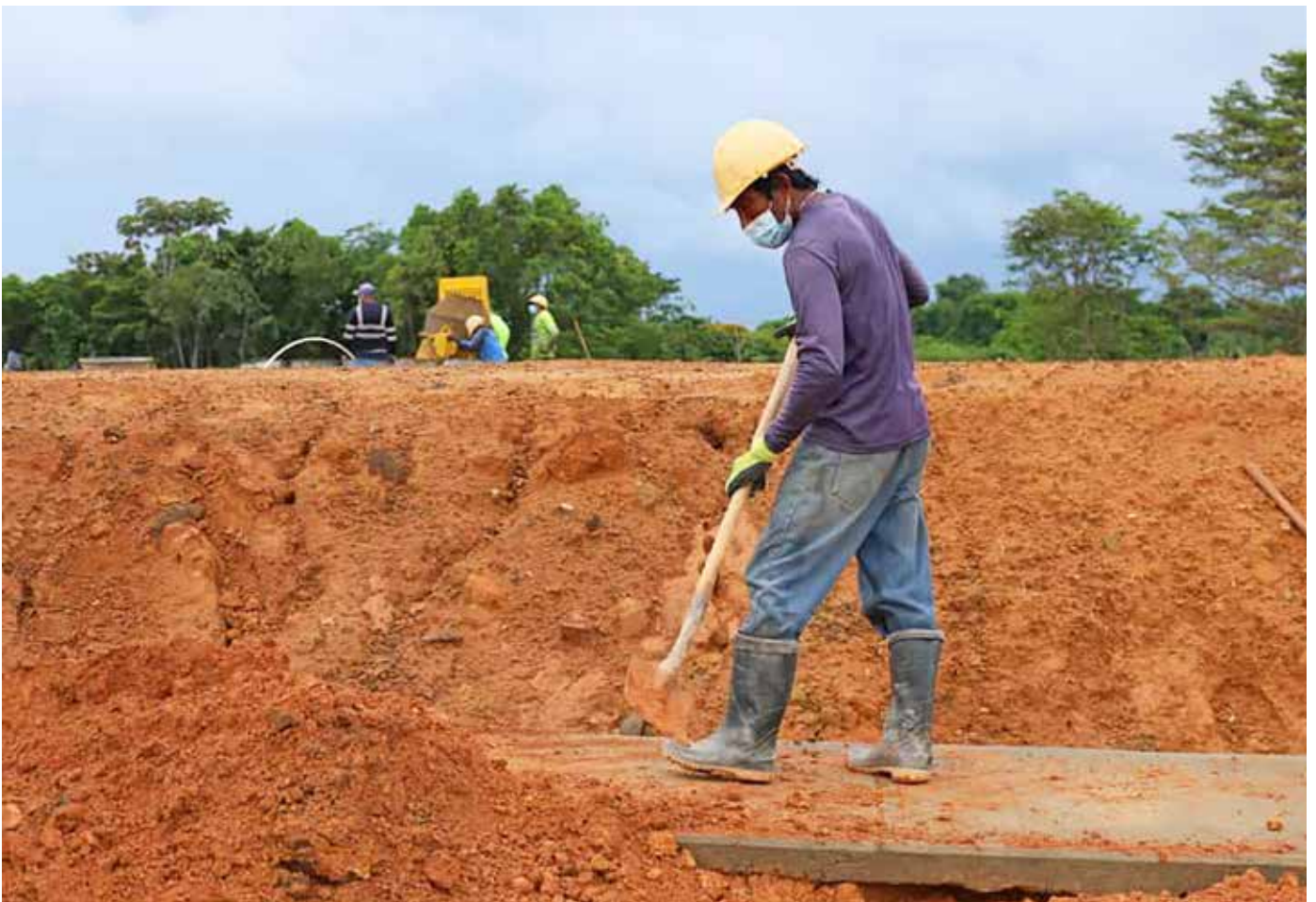
La entidad cuenta con personal del área que va a trabajar en la edificación de las nuevas residencias.
