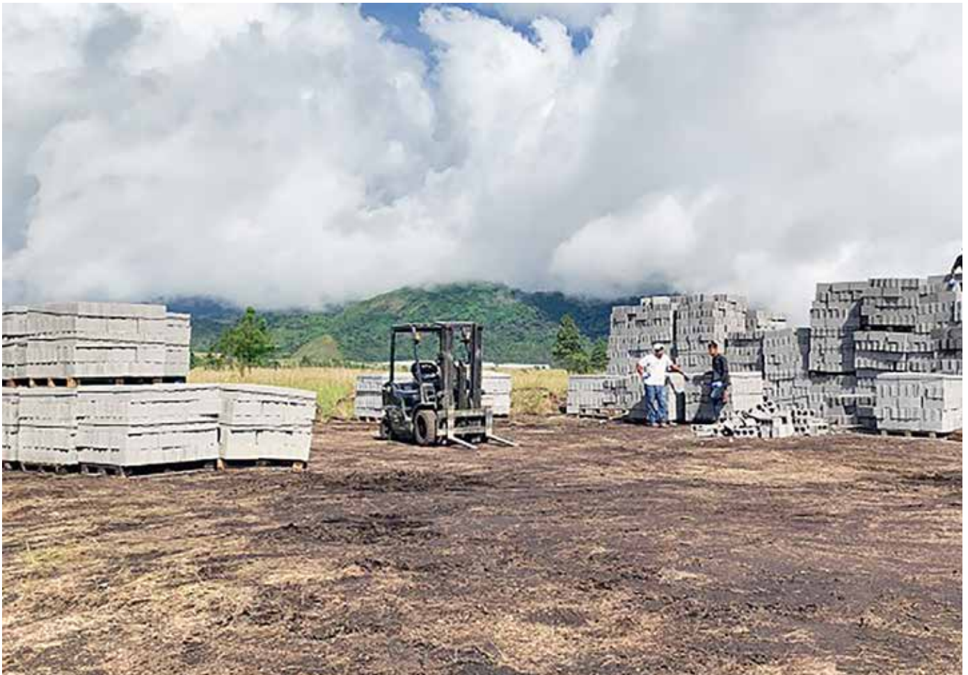
Esta solución habitacional se construye en un terreno de ocho hectáreas.
