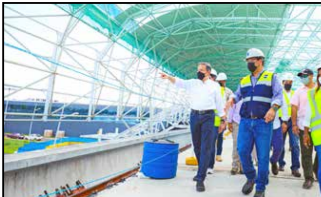
El mandatario hizo un recorrido por el ramal de la Línea 2 del Metro de Panamá en la estación Aeropuerto, que lleva un avance del 85% en obras civiles.
