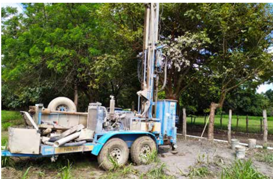
El MIDA cuenta con equipo y cuadrillas para apoyar a los productores.
